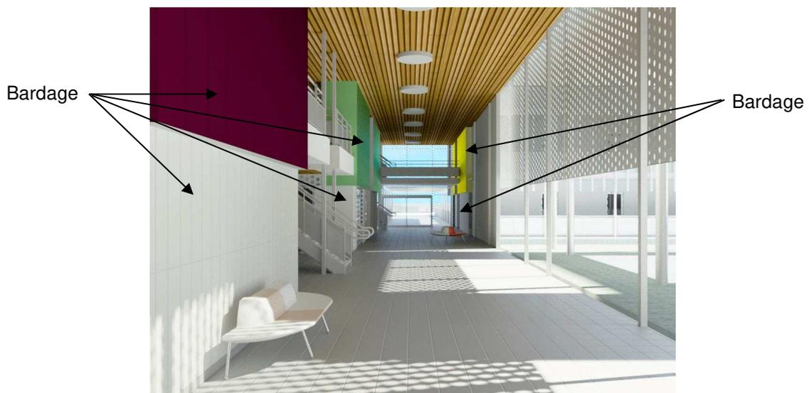
Illustration : Vue intérieure du bloc 0 – Mise en évidence des bardages sur structure légère
